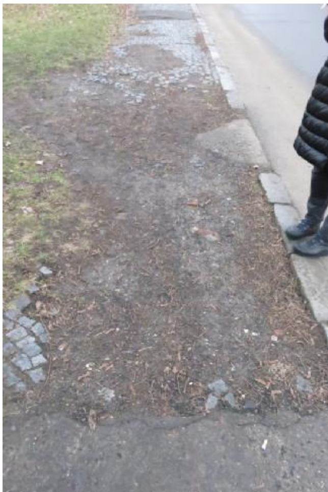
Rozpadající se dlažba z žulové kostky v severní části. V SZ části navazuje nová zámková dlažba lemující východní část.
